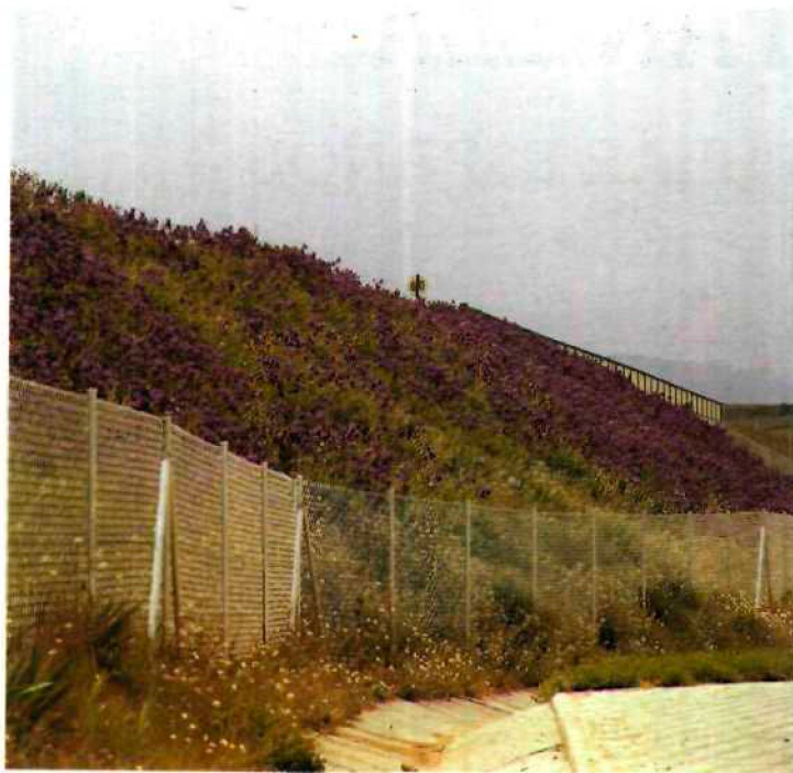
Talud restaurado donde florecen los lirios
