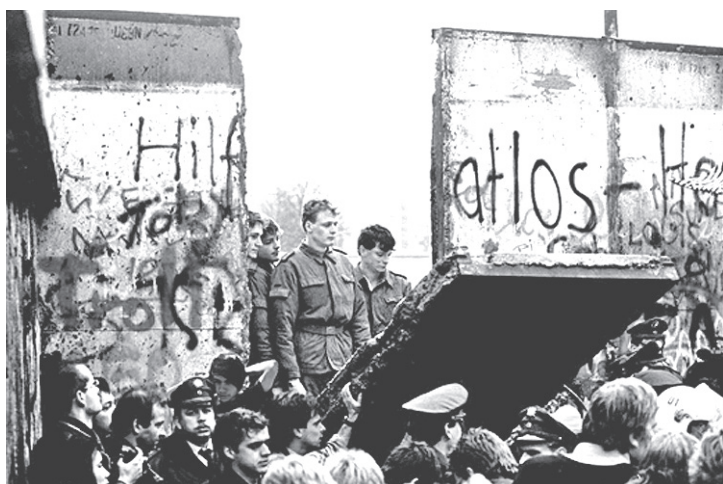
Tras la caída del Muro se desclasificaron archivos de la Stasi.
