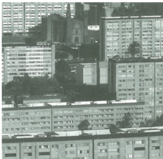
Iglesia de Santiago Tlatelolco, entre los más de cien edificios de una unidad habitacional en el DF.
